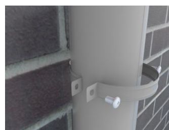
Obejmę skręcamy ze sobą wkrętami tak aby rura nie mogła się wysunąć.
