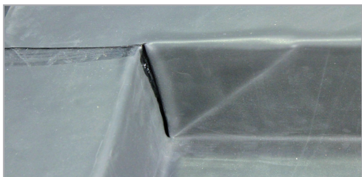
Typowy wygląd narożnika wewnętrznego, bez wykończonej górnej części.
